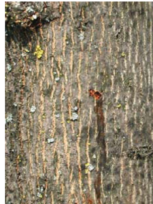
4. Nagestelle mit Safffluss
